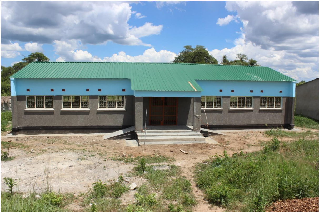
Slik ser klasseroms bygget like før elevene tar det i bruk i mars 2018
